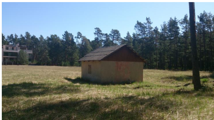
7.attēls. Teritorijā esošā apbūve – sūkņu ēka.
